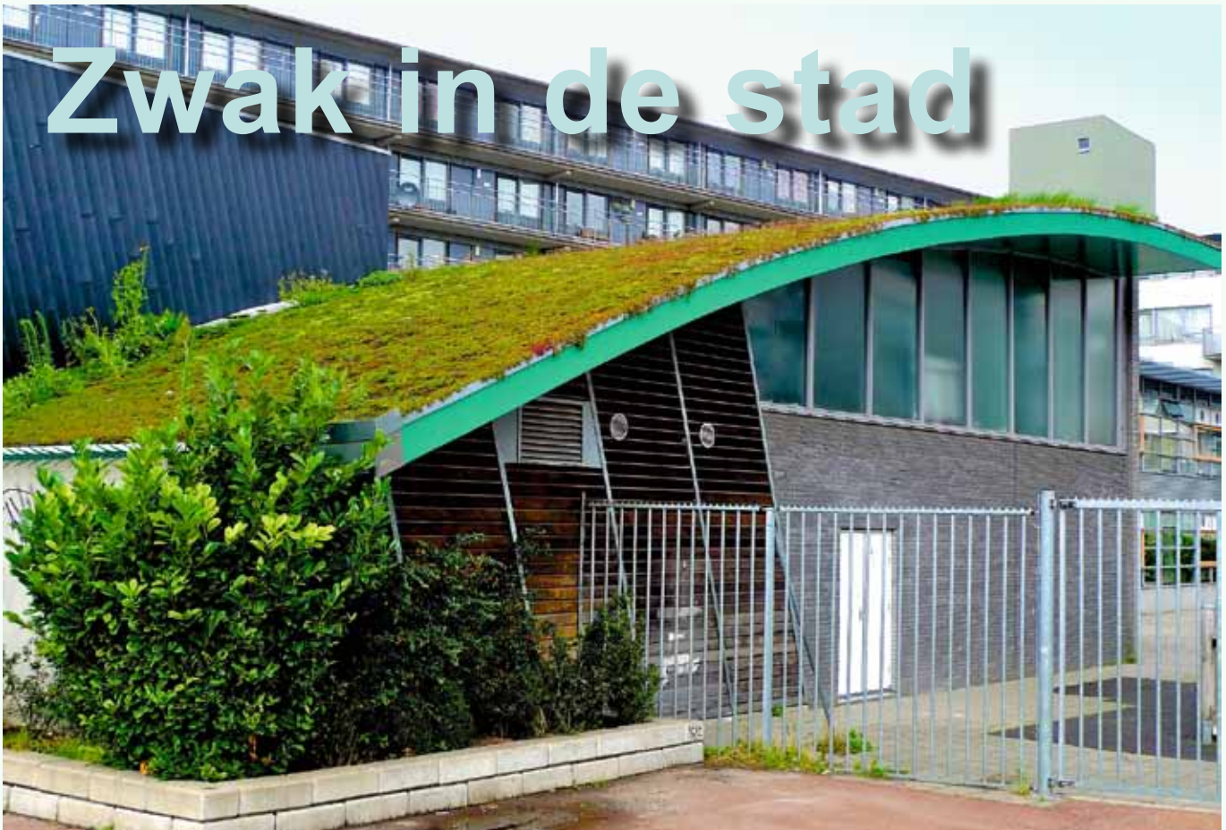
Grasdaken: niet alleen mooi, maar ook een effectieve isolatie tegen hitte. Iets dat op de J. Obrechtstraat (locatie verslavingszorg) zeer gewenst is.
